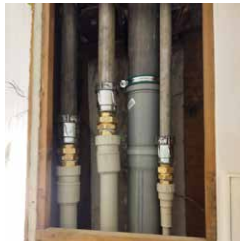
Tymczasowe łączenia starej i nowej instalacji, aby uniknąć przerw w dostawie wody.
