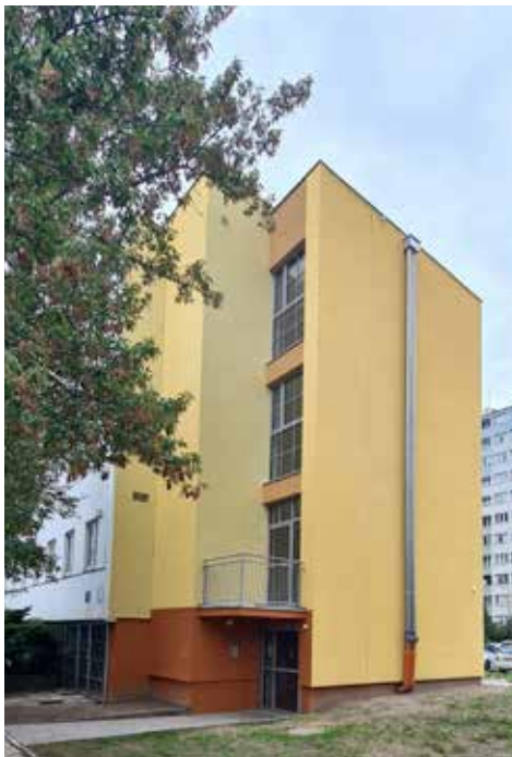
10 września br. nastąpił odbiór zmodernizowanej klatki schodowej wraz z dobudowanym szybem windowym w biurowcu przy ul. Inżynierskiej 72a (fot. W. Lubczyński)
