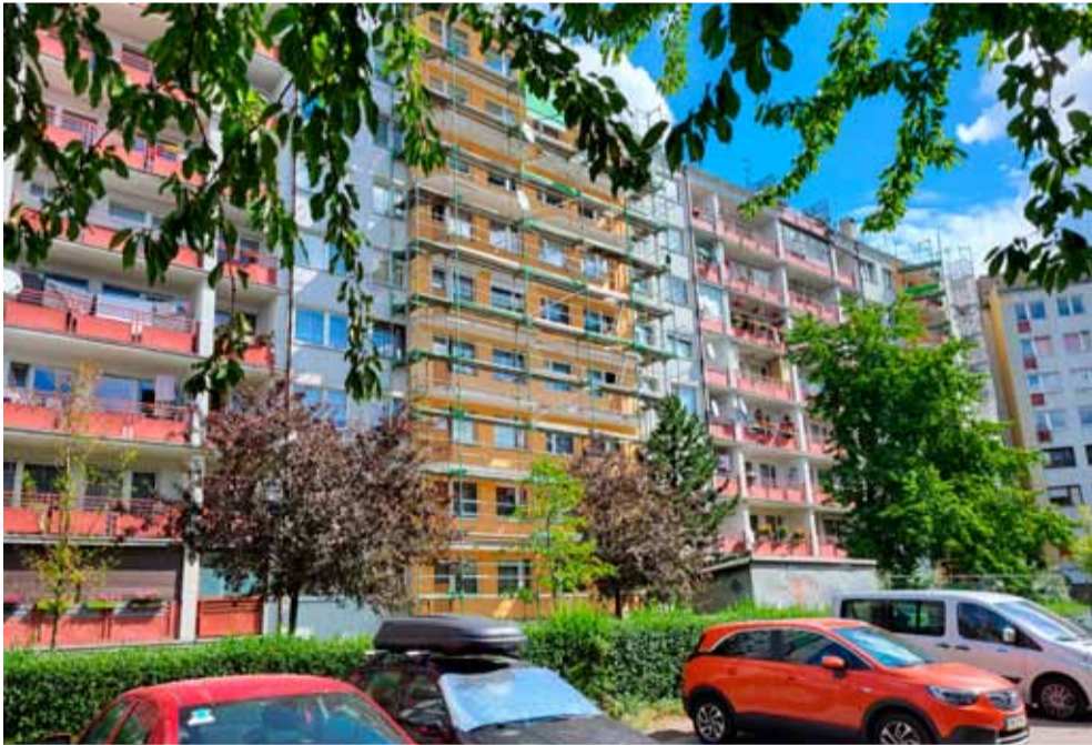
Modernizacja balkonów połączona ze zmianą kolorystyki elewacji na Muchoborze Małym
